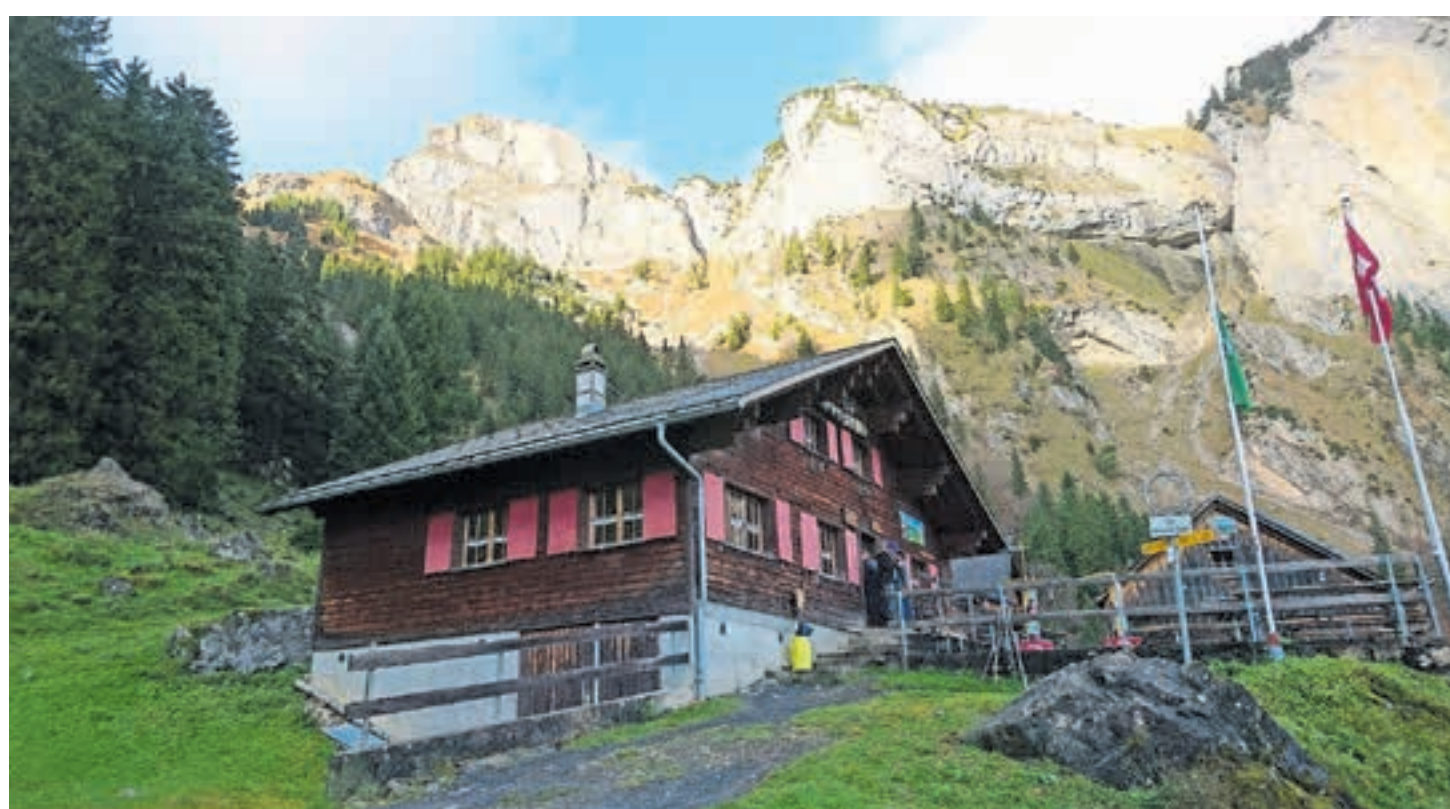
Die Infrastruktur des Berggasthauses Alp Rohr erfüllt die gesetzlichen Anforderungen in mehrerer Hinsicht nicht mehr.
